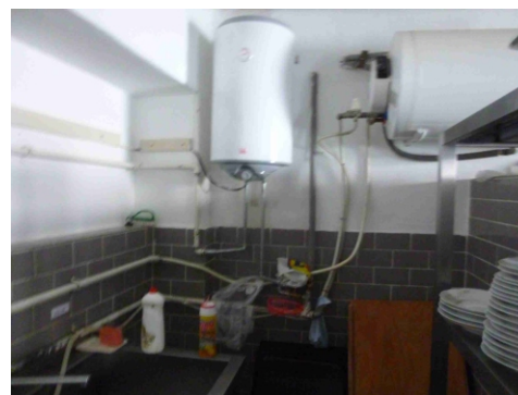
Obr.č.14 Prvky systému prípravy teplej vody
