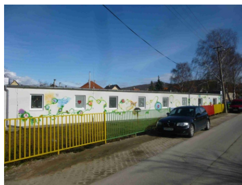
Obr.č.4 Pohľad juhozápadný
