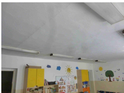
Obr.č.15 Prvky systému umelého osvetlenia
