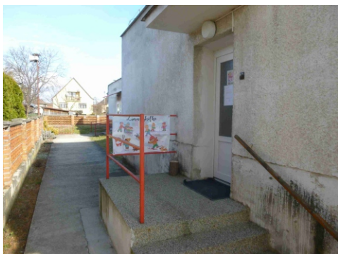
Obr.č.1 Pohľad severozápadný
