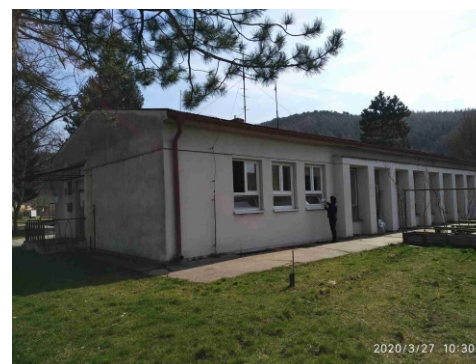
Obr.č.4 Pohľad západný
