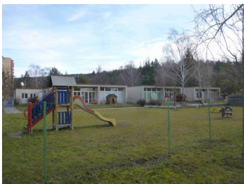
Obr.č.1 Pohľad severovýchodný
