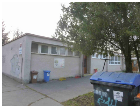
Obr.č.2 Pohľad juhovýchodný
