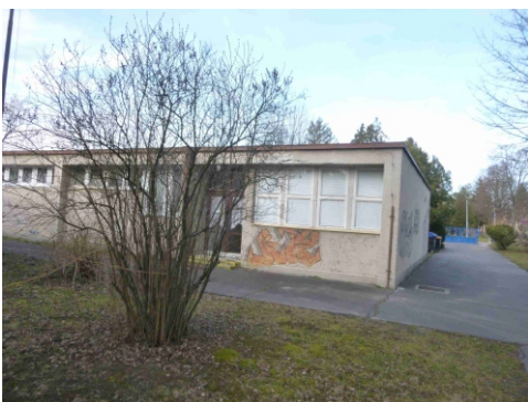
Obr.č.3 Pohľad severozápadný
