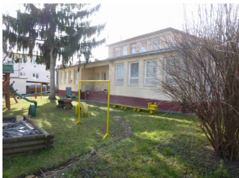
Obr.č.1 Pohľad severovýchodný
