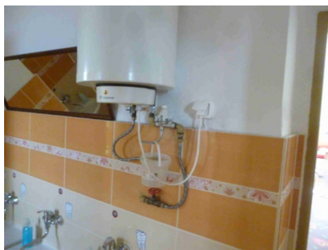
Obr.č.13 Prvky systému prípravy teplej vody
