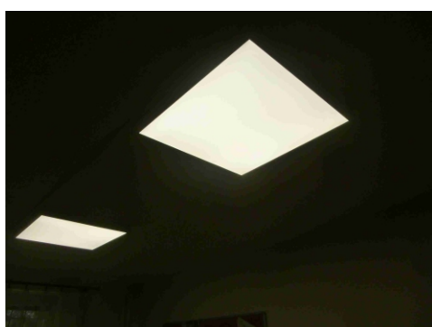
Obr.č.16 Prvky systému umelého osvetlenia
