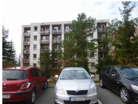
Obr.č.2 Pohľad východný
