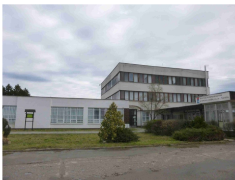
Obr.č.3 Pohľad juhozápadný
