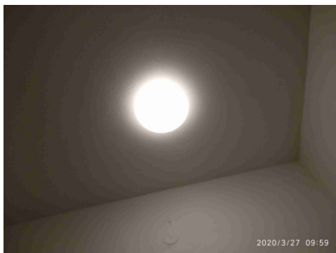
Obr.č.15 Prvky systému umelého osvetlenia
