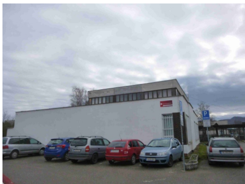
Obr.č.1 Pohľad severozápadný
