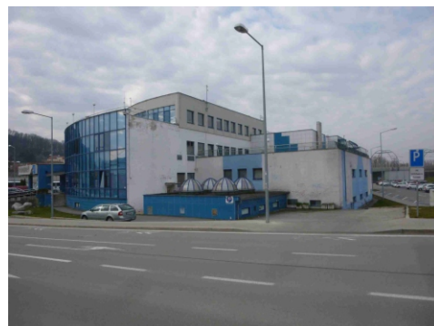
Obr.č.2 Pohľad severovýchodný
