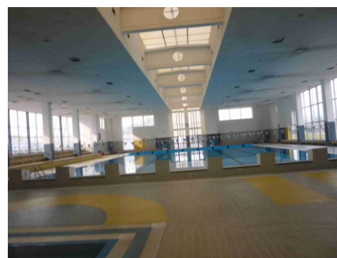
Obr.č.16 Prvky systému umelého osvetlenia
