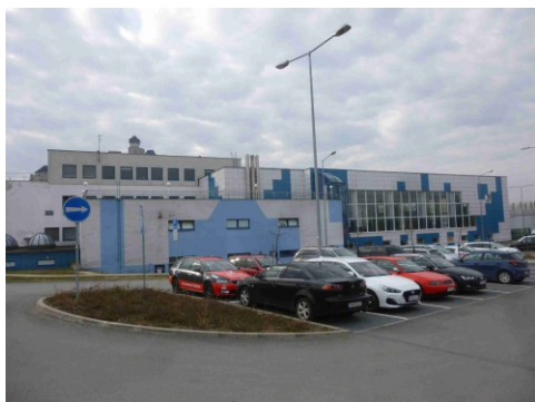
Obr.č.1 Pohľad severozápadný
