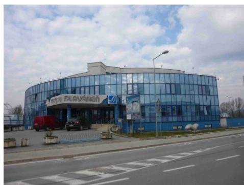
Obr.č.4 Pohľad juhovýchodný
