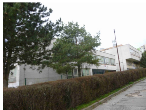
Obr.č.2 Pohľad východný
