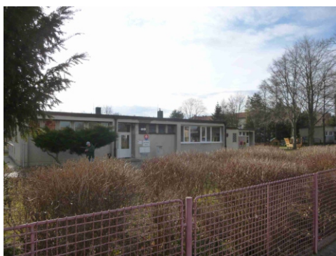
Obr.č.3 Pohľad severozápadný
