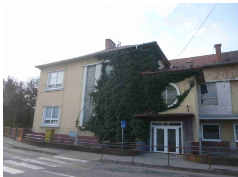
Obr.č.1 Pohľad severovýchodný
