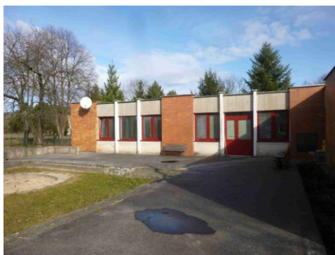
Obr.č.3 Pohľad severovýchodný
