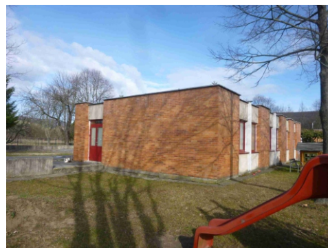
Obr.č.2 Pohľad juhovýchodný
