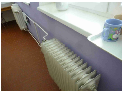
Obr.č.9 Prvky systému vykurovania
