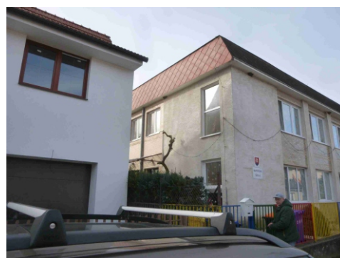
Obr.č.2 Pohľad východný
