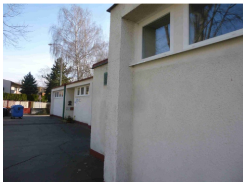
Obr.č.1 Pohľad severný
