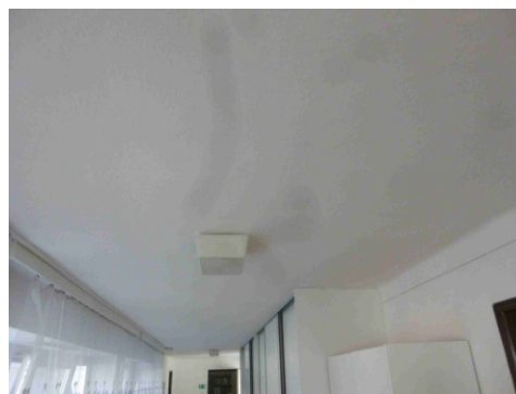
Obr.č.16 Prvky systému umelého osvetlenia
