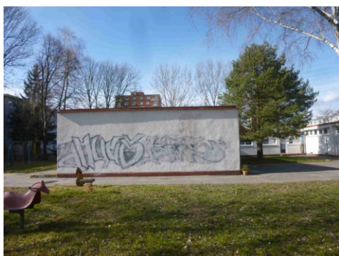
Obr.č.3 Pohľad južný
