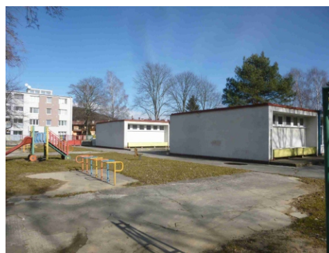
Obr.č.4 Pohľad západný
