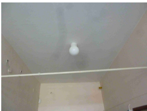
Obr.č.15 Prvky systému umelého osvetlenia
