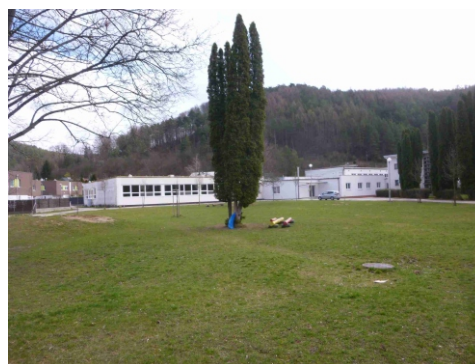
Obr.č.4 Pohľad západný
