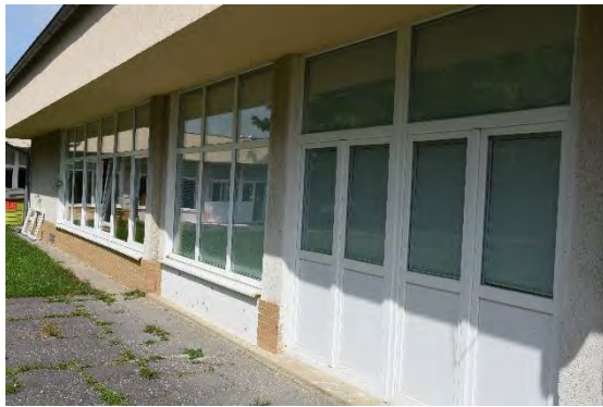
Stred: Výmena okien a dverí v MŠ Stromová
