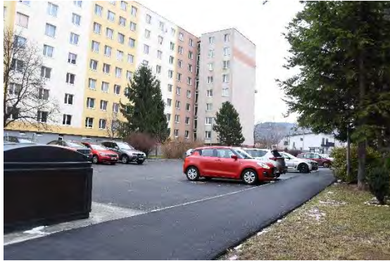
Sever: Rekonštrukcia cesty na Clementisovej
