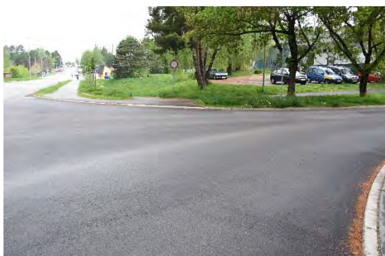
Juh: Rekonštrukcia cesty na Západnej ulici
