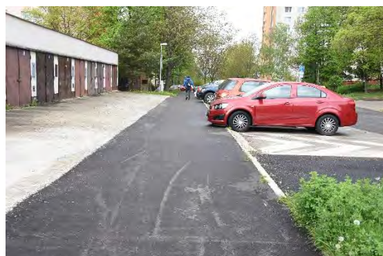
Juh: Rekonštrukcia chodníkov na Západnej ulici
