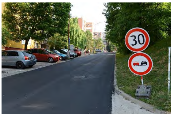
Juh: Rekonštrukcia cesty Liptovská-Šafárikova
