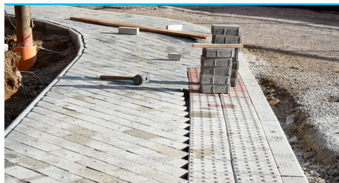
Koncom roka sa ukončovali práce na rekonštrukcii ďalších chodníkov, napr. na ul. M. Bela, kde mesto vybudovalo aj nový chodník a kde sa obnovili i schodiská.
