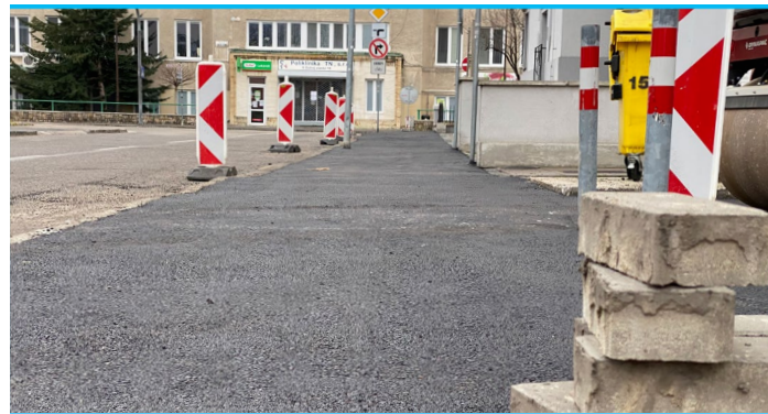
Chodník a parkovisko v blízkosti Domu opatrovateľských služieb mesta Trenčín na Piaristickej ulici majú už nový asfaltový povrch.
