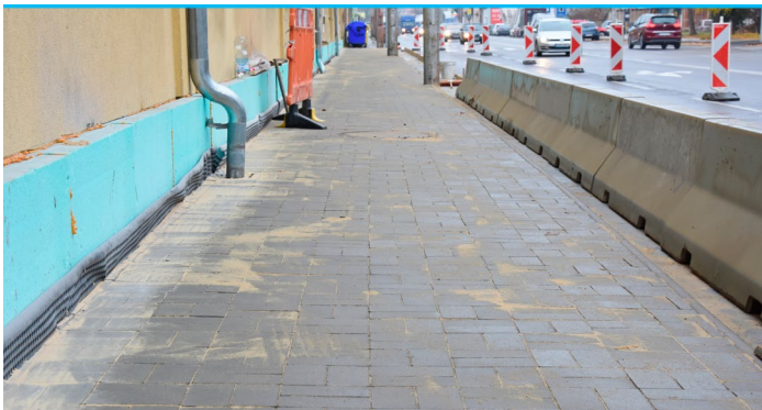
Mesto rekonštruje viaceré komunikácie pre peších. Chodník na Ulici gen. M. R. Štefánika už má novú dlažbu. Vynovia i chodníky na Piešťanskej ulici.
