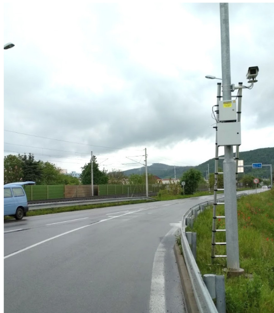
Obr. 12 príklad umiestnenia priemyslovej kamery NT
