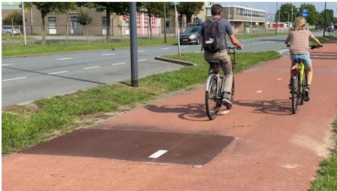
Obrázok 12 Reaktívna oprava povrchov. Zdroj: bicycledutch.wordpress.com
