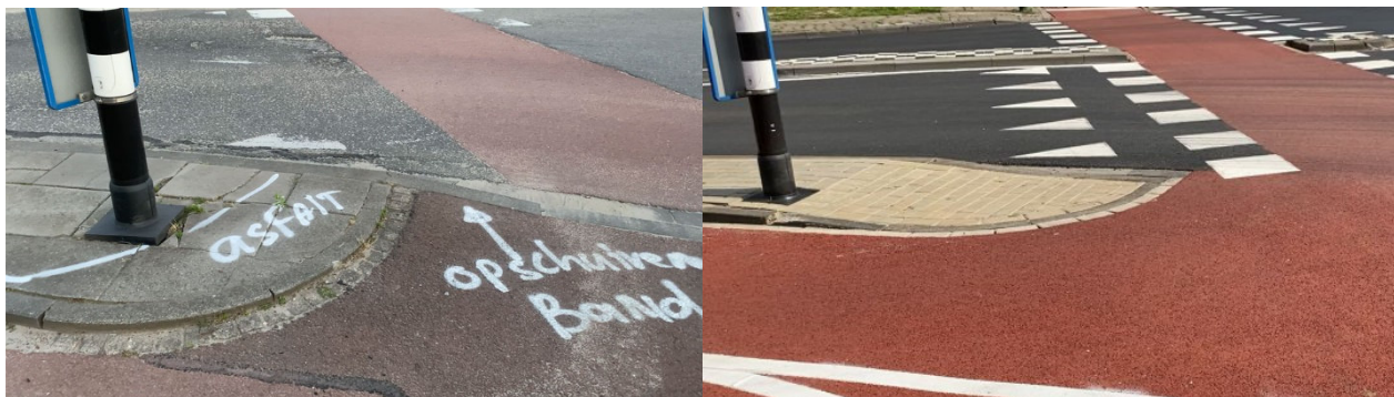
Obrázok 13 Pred a po úprave s naznačením potrebných úprav a opráv - obnovenie značenia a zníženie nebezpečného obrubníku. Zdroj: bicycle-dutch.wordpress.com/.
