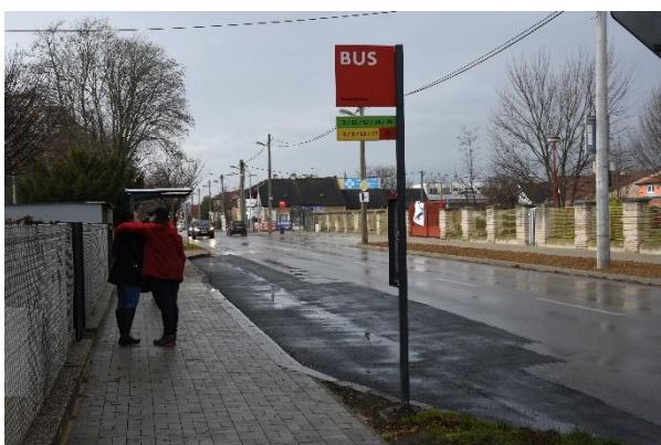
Stred: Obnova zastávky a chodníka Legionárska.
