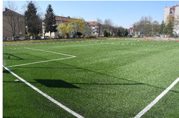
Sever: Výmena umelého trávnik na ZŠ Hodžova.
