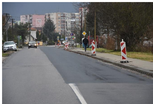
Sever: Rekonštrukcia cesty na Opatovskej ulici.
