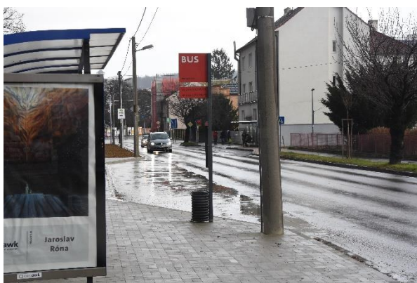
Stred: Obnova zastávky a chodníka Legionárska.
