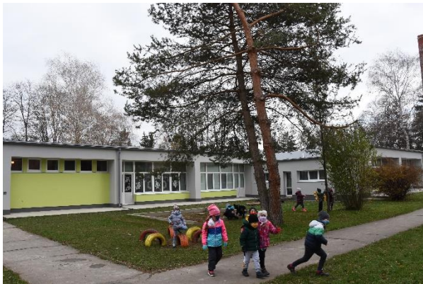
Sever: Rekonštrukcia MŠ na Ulici M. Turkovej.
