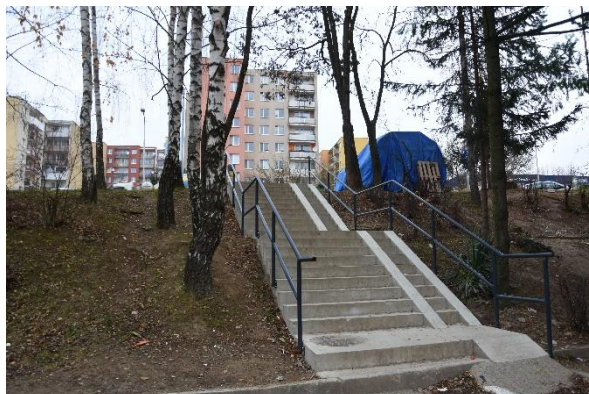
Juh: Rekonštrukcia schodiska na Halalovke.
