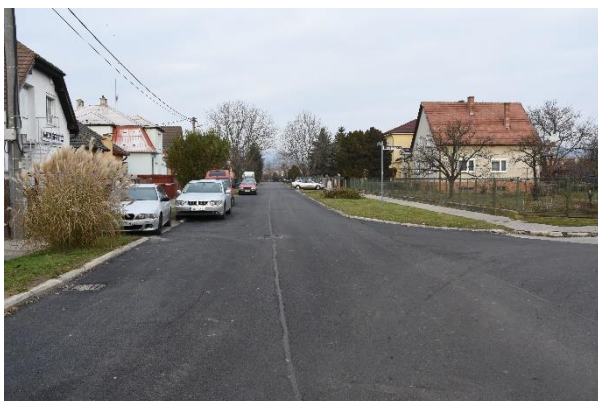
Stred: Rekonštrukcia cesty na Javorinskej ulici.
