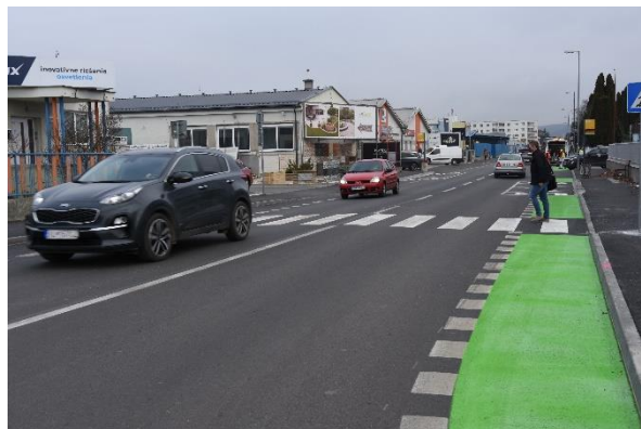
Západ: Rekonštrukcia Zlatovskej ulice.
