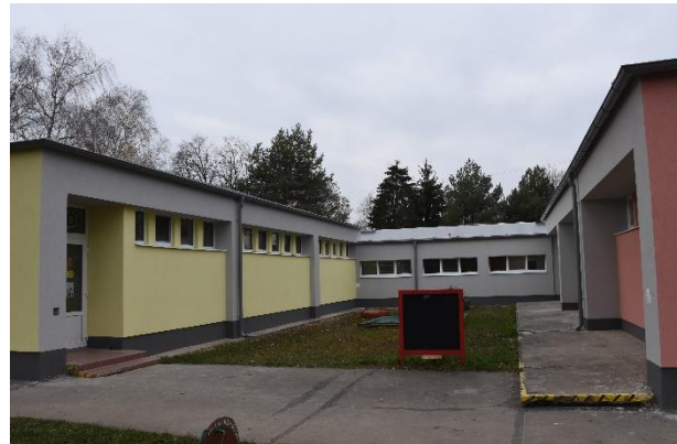
Sever: Rekonštrukcia MŠ na Ulici M. Turkovej.
