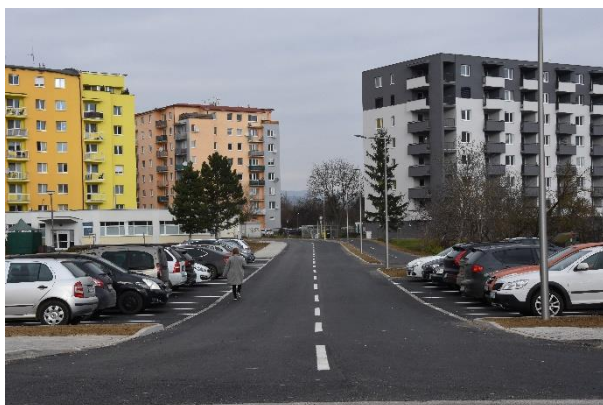
Sever: Napojenie Opatovskej na Armádnú ulicu.
