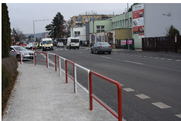
Západ: Rekonštrukcia Zlatovskej ulice.
