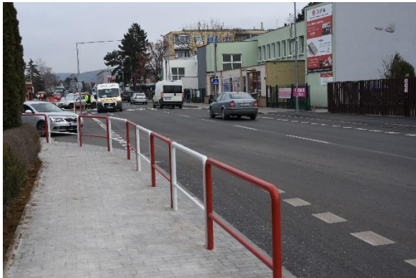
Západ: Rekonštrukcia Zlatovskej ulice.
