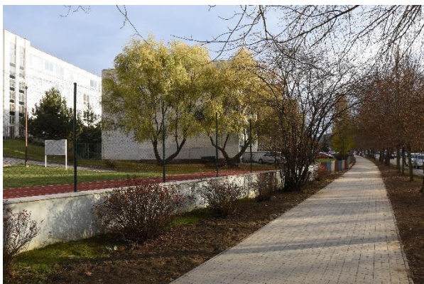
Juh: Rekonštrukcia chodníka na Východnej.
