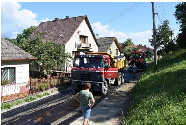
Sever: Rekonštrukcia ciest v Kubrej.
