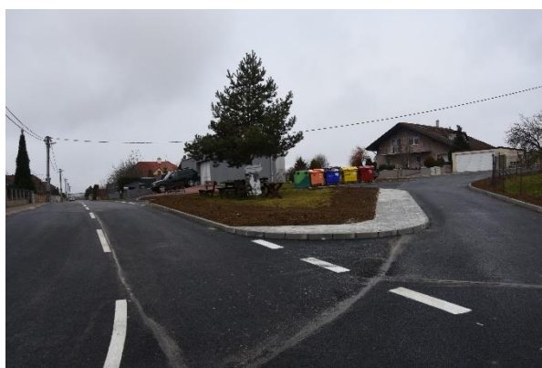
Stred: Rekonštrukcia ciest na ulici Pod Komárky.
