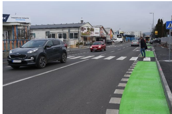
Západ: Rekonštrukcia Zlatovskej ulice.
