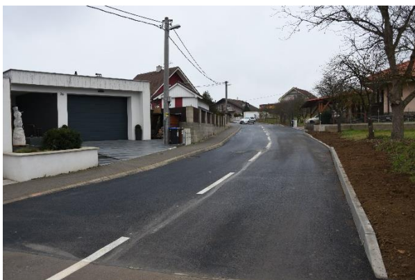
Stred: Rekonštrukcia ciest na ulici Pod Komárky.
