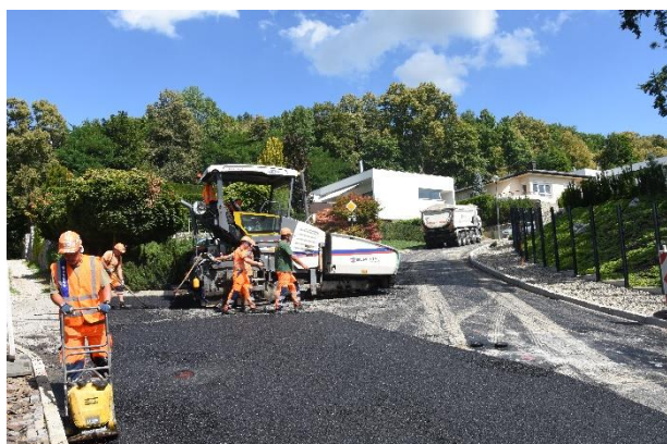
Stred: Rekonštrukcia cesty na ulici Pod Brezinou.
