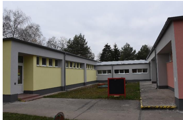
Sever: Rekonštrukcia MŠ na Ulici M. Turkovej.
