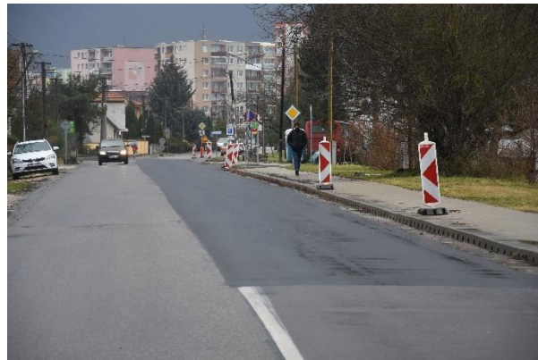
Sever: Rekonštrukcia cesty na Opatovskej ulici.
