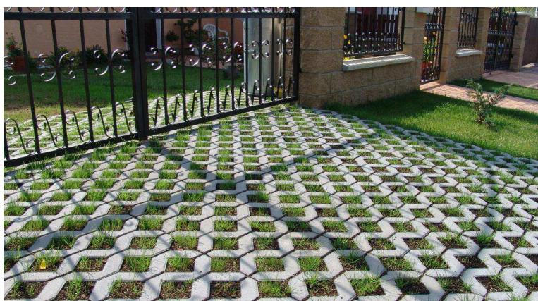
Betónová zatrávňovacia dlažba sa v súčasnosti vyrába v rôznych tvaroch a dekóroch. Dlažba je tvorená betónovými tvárnicami, ktoré sa kladú na zhutnený povrch. Nevýhodou betónového materiálu je, že betón do seba absorbuje aj určitý objem vody a tráva veľmi často zoschne. S absorpciou je spojené aj to, že betónová dlažba má menšiu odolnosť voči mrazu v zime.
