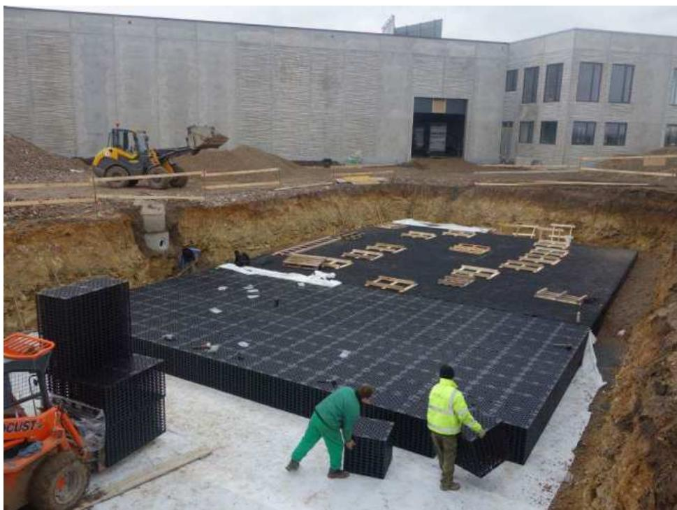
Využitie je vhodné pre lokality s obmedzeným priestorom a s nízkymi nárokmi na čistenie povrchového odtoku. Objem zariadenia je daný na požiadavky na maximálny odtok z povodia. Je regulovaný ventilom na odtok z retenčného priestoru.
