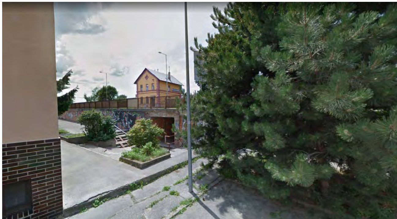
Obr. 9 Príklad priestorovej hierarchie: krátke a bezpečné prepojenie, ale zároveň nekomunikujúci, temný a opustený podchod ku stanici Trenčín predmestie, tiesniaci chodcov pod frekventovanou cestou. Zdroj: Google maps (2014).
