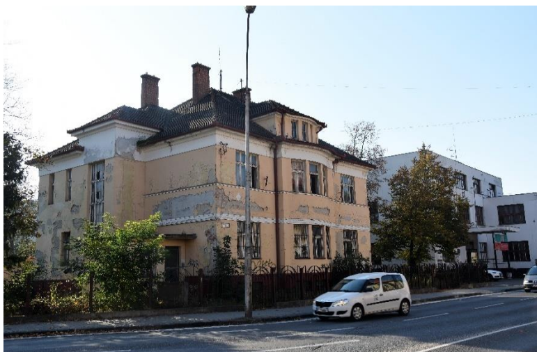
Budova pri kine Hviezda tesne pred asanáciou.
