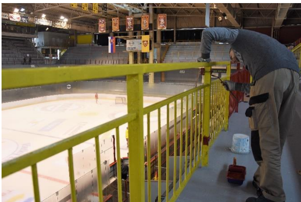
Pondelok 9. septembra – natieranie zábradlia.
