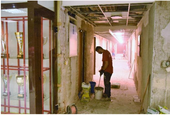
Piatok 5. júla – rekonštrukcia vstupnej haly a chodieb.
