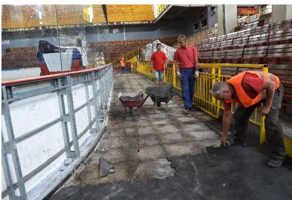
Streda 19. júna – odstraňovanie starej gumenej podlahy.
