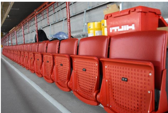
Pondelok 9. septembra – namontované prvé nové sedačky.
