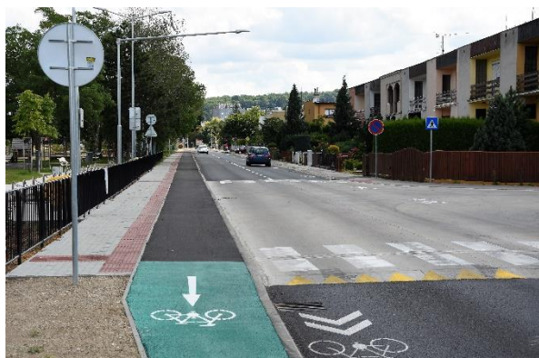
Stred: Rekonštrukcia Karpatskej ulice.
