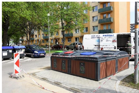
Stred: Polopodzemné kontajnery na Olbrachtovej ulici.
