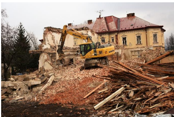
Stred: Asanácia budovy pri kine Hviezda.
