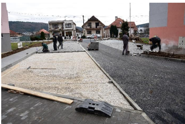
Sever: Parkoviská a spojovacia komunikácia na Opatovskej ulici.
