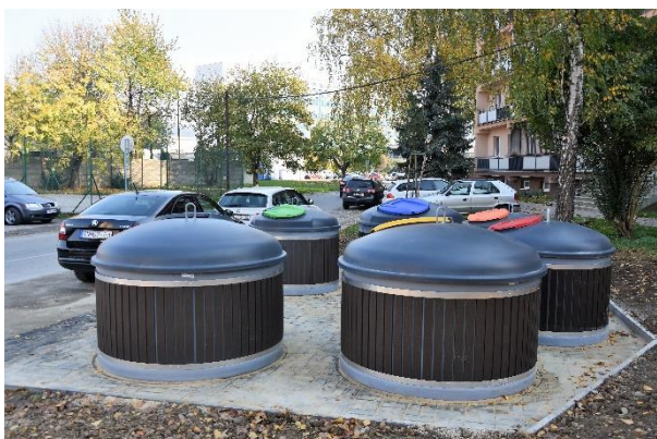
Sever: Polopodzemné kontajnery na ulici K výstavisku.
