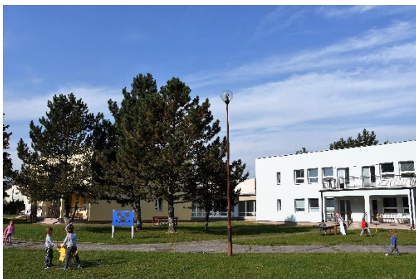
Sever: Komplexná rekonštrukcia Materskej školy Kubranská.
