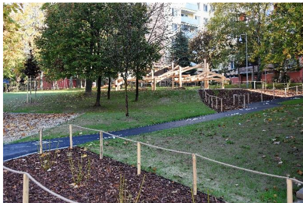
Juh: Rekonštrukcia vnútrobloku na Ulici Jána Halašu.
