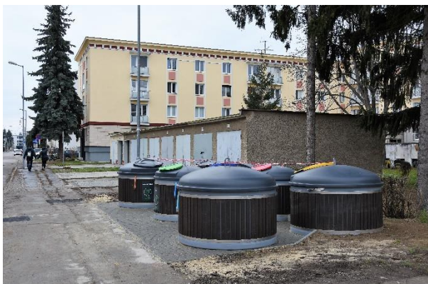
Sever: Polopodzemné Kontajnery na Hurbanovej ulici.
