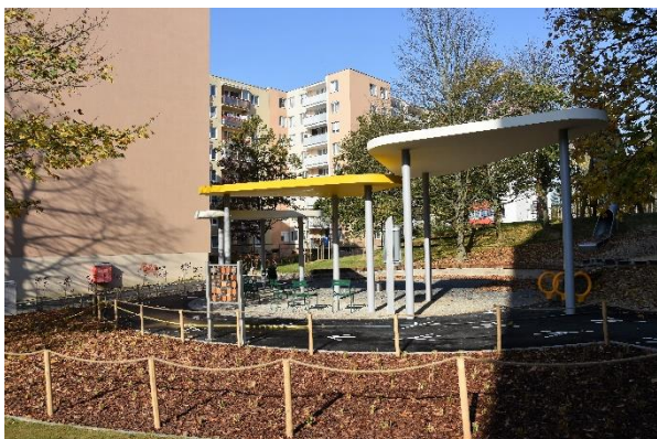
Juh: Rekonštrukcia vnútrobloku na Ulici Jána Halašu.
