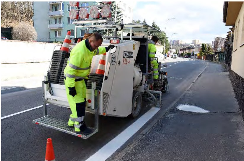
Vodorovné dopravné značenie obnovovali aj na Partizánskej ulici.
