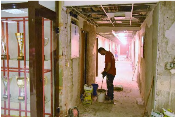
Piatok 5. júla – rekonštrukcia vstupnej haly a chodieb.
