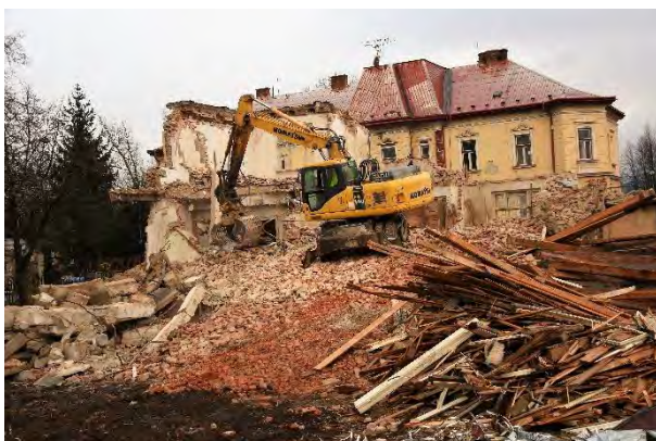
Stred: Asanácia budovy pri kine Hviezda.
