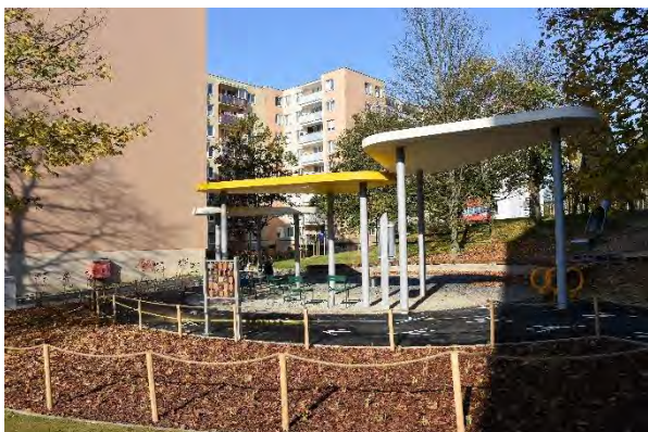
Juh: Rekonštrukcia vnútrobloku na Ulici Jána Halašu.
