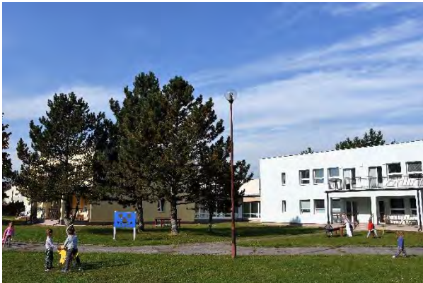
Sever: Komplexná rekonštrukcia Materskej školy Kubranská.
