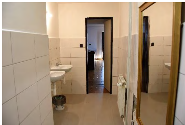
Západ: Rekonštrukcia sociálnych zariadení v KS Zlatovce.
