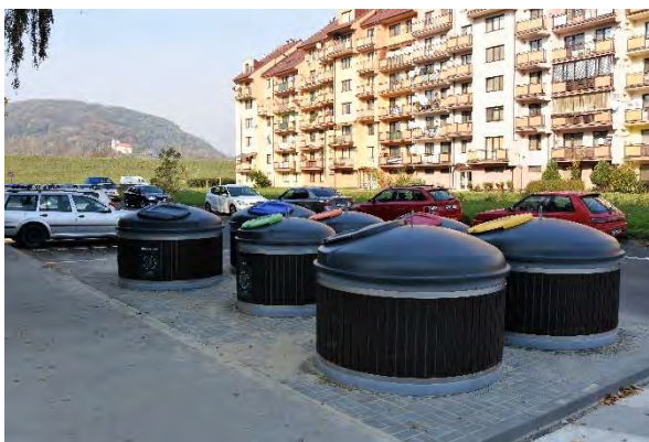
Sever: Polopodzemné kontajnery na Sibírskej ulici.
