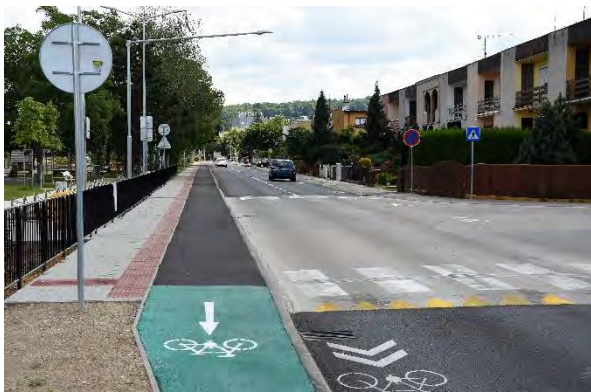
Stred: Rekonštrukcia Karpatskej ulice.
