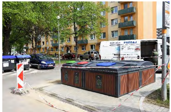
Stred: Polopodzemné kontajnery na Olbrachtovej ulici.
