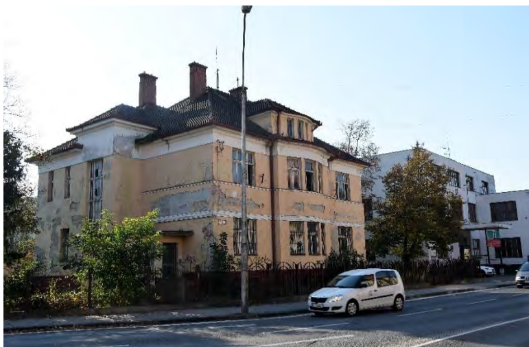
Budova pri kine Hviezda tesne pred asanáciou.
