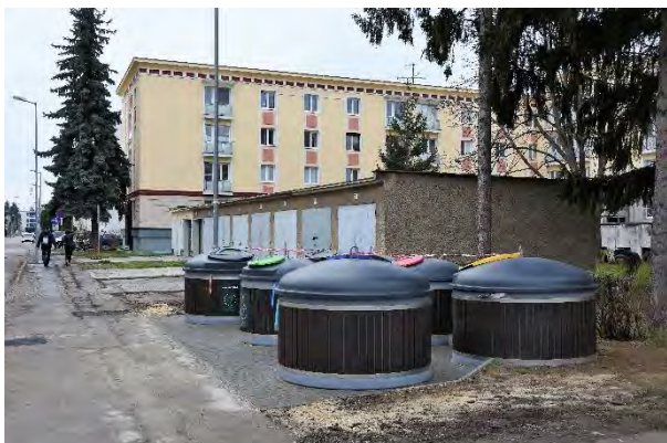
Sever: Polopodzemné Kontajnery na Hurbanovej ulici.
