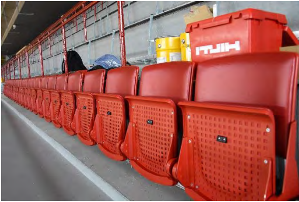
Pondelok 9. septembra – namontované prvé nové sedačky.
