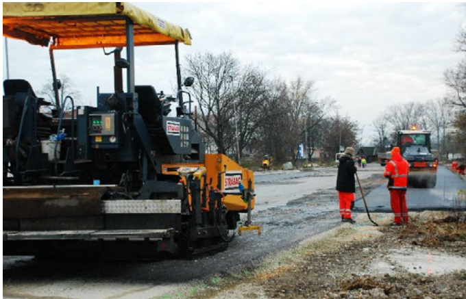
Na Mládežníckej ulici vybudovali 140 parkovacích miest.
