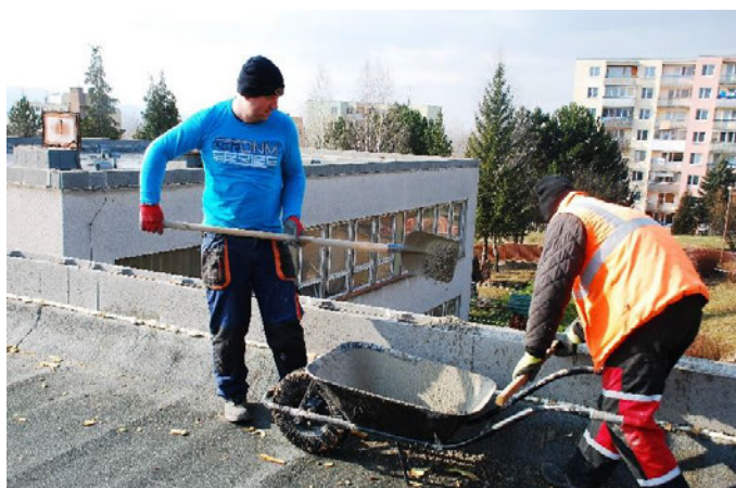
Na budove MŠ Šafárikova sa začala rekonštrukcia strešného plášťa.
