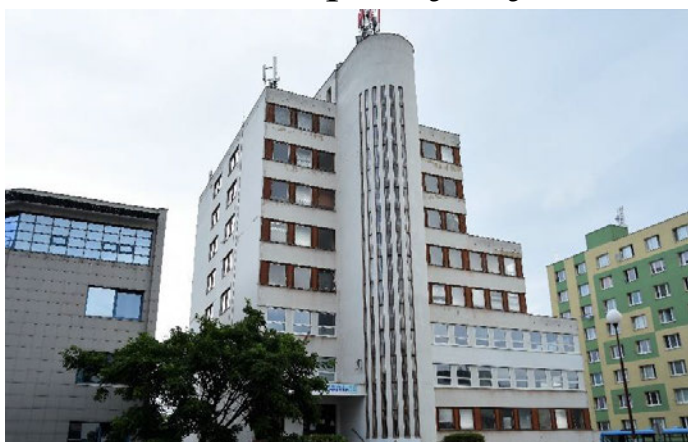
Osemposchodová budova, v ktorej sídli súkromné gymnázium Futurum.
