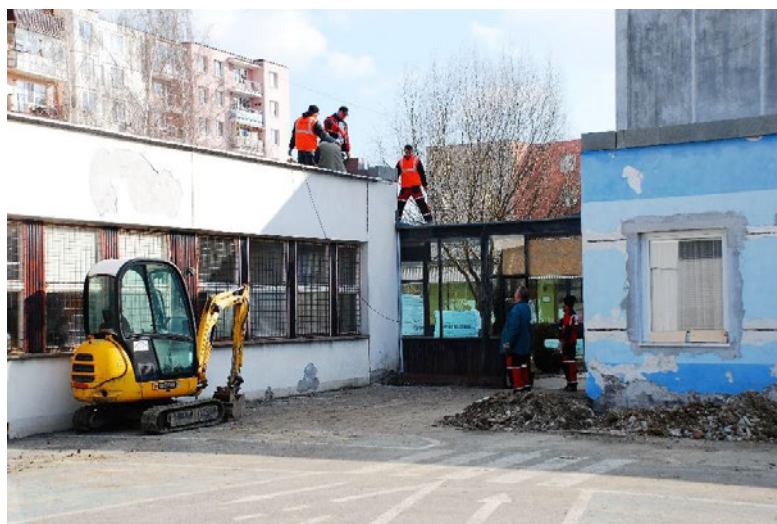
Rekonštrukčné práce sa rozbehli aj v areáli MŠ Opatovská.
