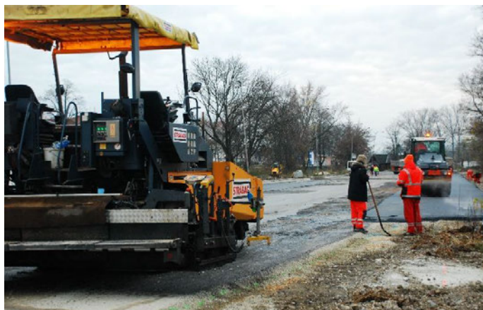
Na Mládežníckej ulici vybudovali 140 parkovacích miest.
