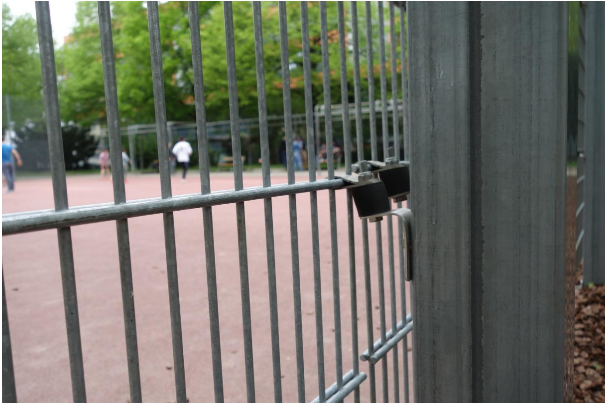
Detail uchytienia ochranného pletiva znižujúceho hluk dopadajúcej lopty o pletivo (Viedeň)
