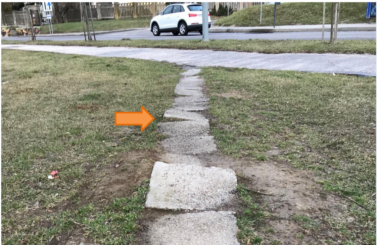
15. Chodník pri „dele“ – Soblahovská/Bezručová. Bolo by možné vyrovať kocky na chodníku popri dele, ktoré sú dnes v niektorých častiach pod rôznym sklonom.
