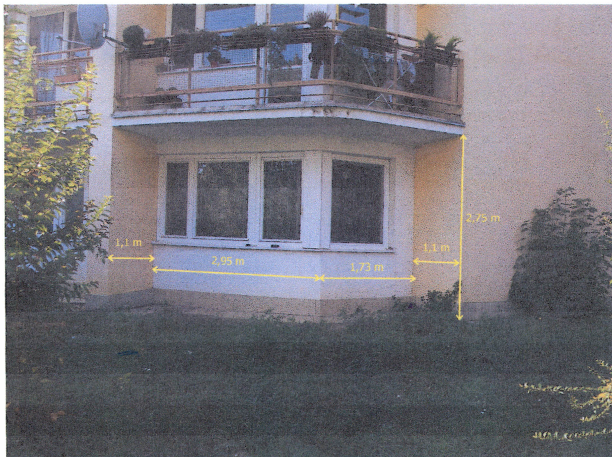
Fotografia 4 Pohľad na miesto stavebnej úpravy s rozmermi
