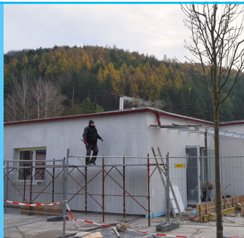
V MŠ na Kubranskej ulici sa začali prvé práce na jej rekonštrukcii. Bude zateplená s modernizovaným vykurovaním, osvetlením a vzduchotechnikou. Práce na spojovacej chodbe základnej školy v susedstve škôlky sú v záverečnej fáze.
