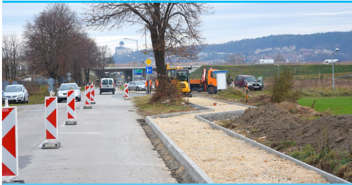
Mesto buduje nový chodník v úseku čistiarene odpadových vôd v smere z Nozdrkoviec do Biskupíc. Ide o 1. etapu chodníka, ďalšia je v prípravnom procese.
