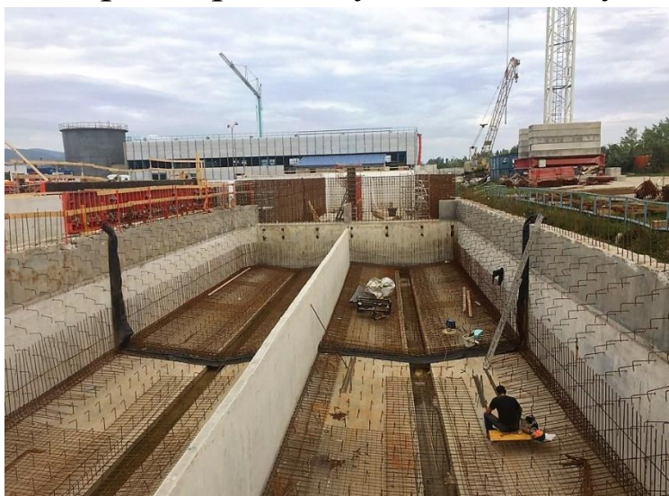
Rekonštrukcia čistiarne odpadových vôd v Nemšovej.
