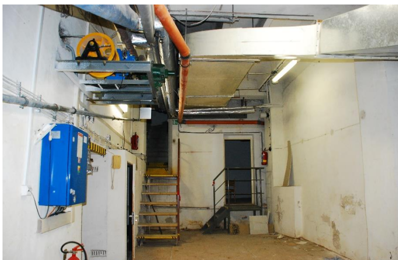
Kino potrebuje aj novú kotolňu, vzduchotechniku a rozvody elektriny a kúrenia.
