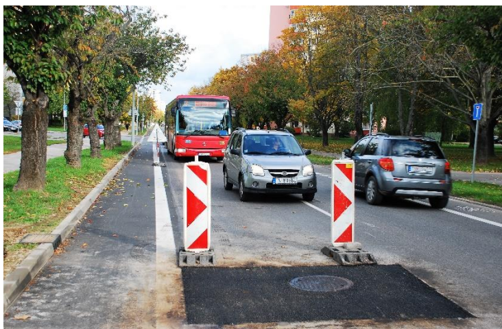
Úprava výšky poklopov na Soblahovskej ulici.
