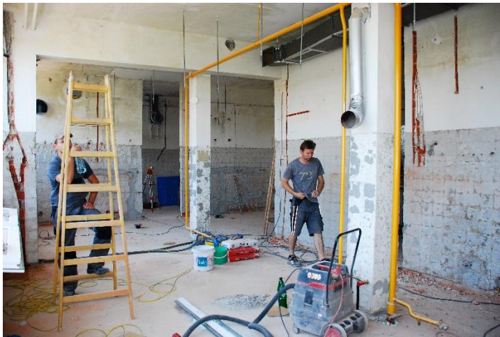
Mesto rekonštruovalo priestory kuchyne v ZŠ na Veľkomoravskej ulici.
