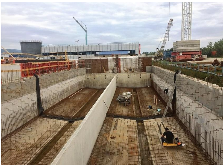
Rekonštrukcia čistiarne odpadových vôd v Nemšovej.
