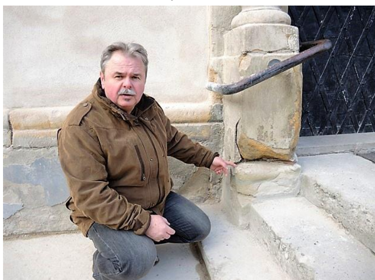
Reštaurátor Juraj Krajčo: „Budova potrebovala dýchať.“
