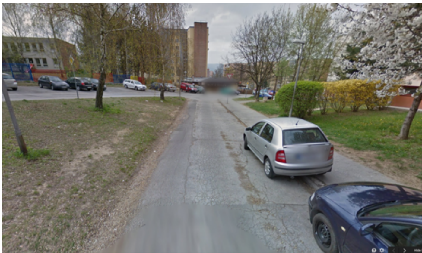
1, Laca Novomeského , párne čísla, prepádajúci sa pás komunikácie (50m)
