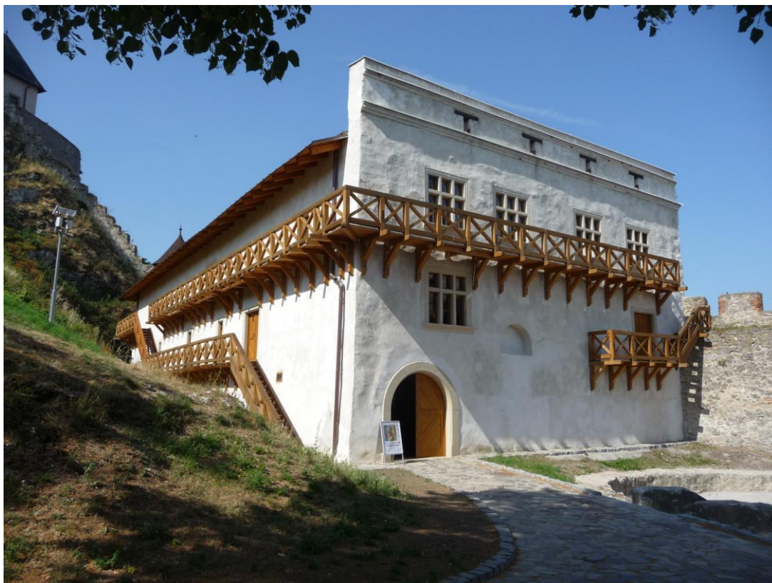
8. Zrekonštruovaný objekt kasární na dolnom nádvorí- východná a severná fasáda
