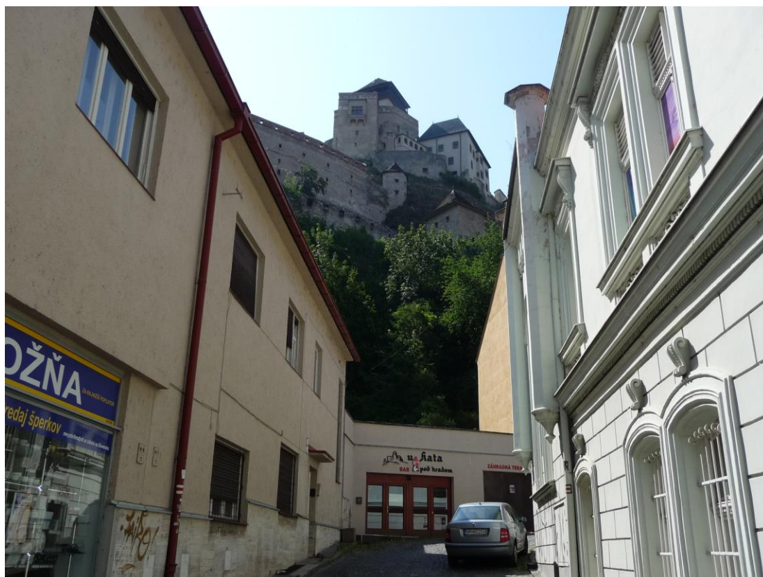
22. Významný interiérový pohľad MPR – z Matušísovej ulice na hrad
