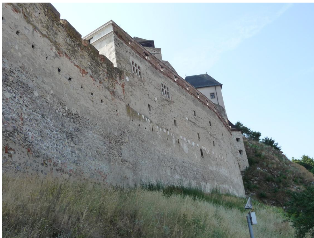
5. Pohľad z prístupovej cesty na hrad za 1. bránou na objekt kasárni
