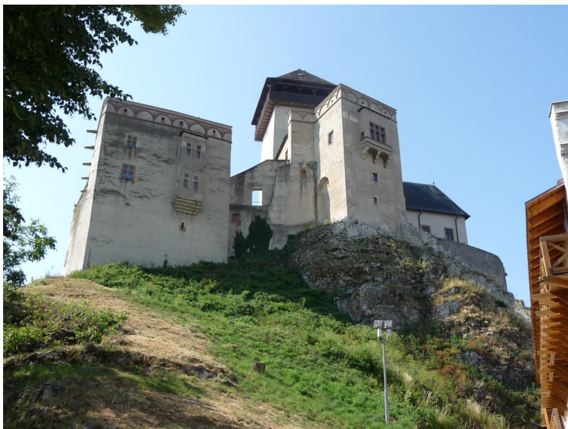
9. Pohľad z dolného hradu na hradné jadro (zľava Barborin palác, Ľudovítov palác, Palác Zápoľských, v pozadí Matúšova veža)
