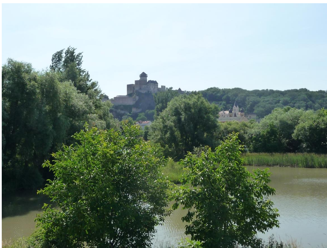
Pohľad č. 8 - z pravobrežnej hrádze- od starého železničného mosta
