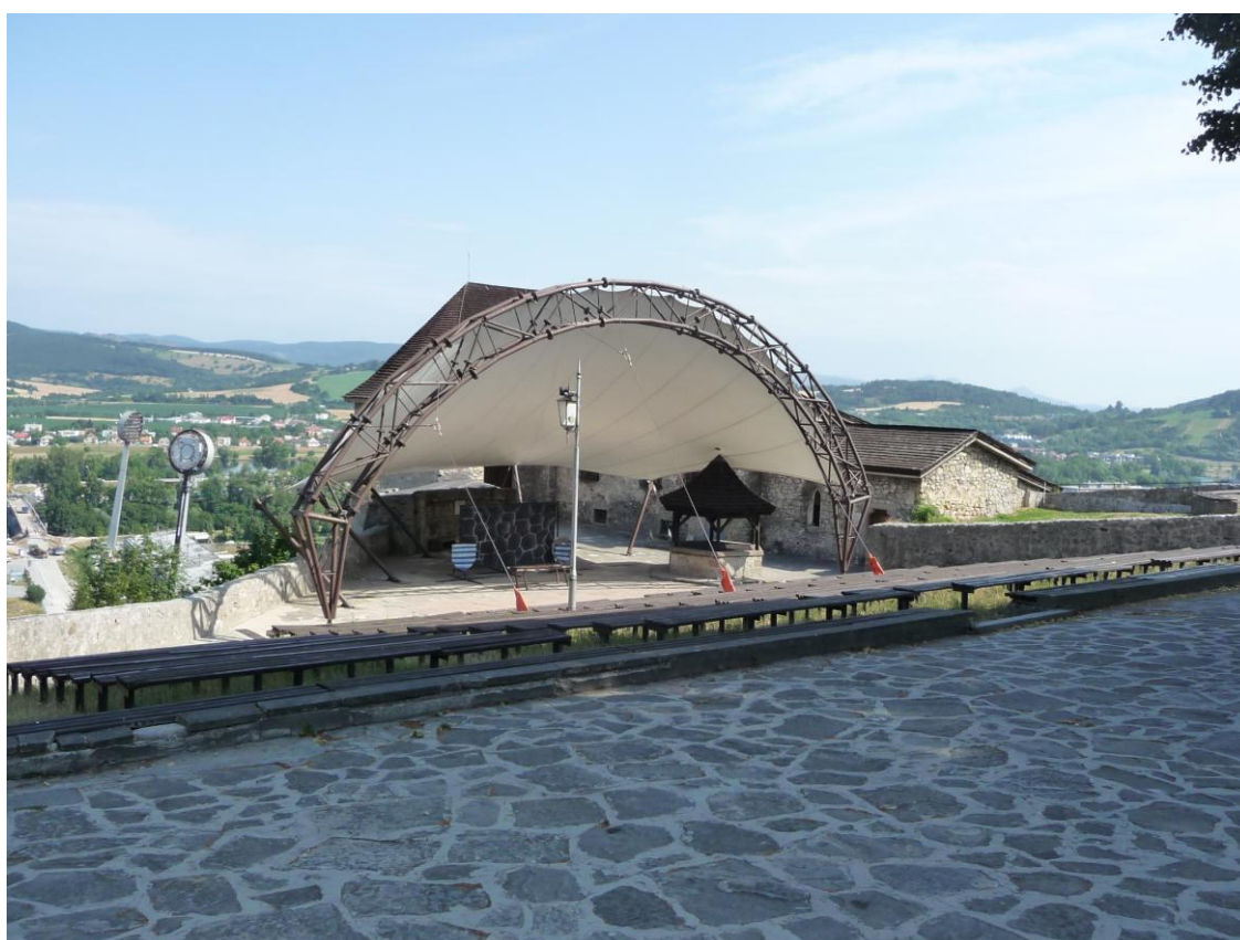
7. Dolné nádvorie- dočasná konštrukcia prestrešenia pódia amfiteátra
