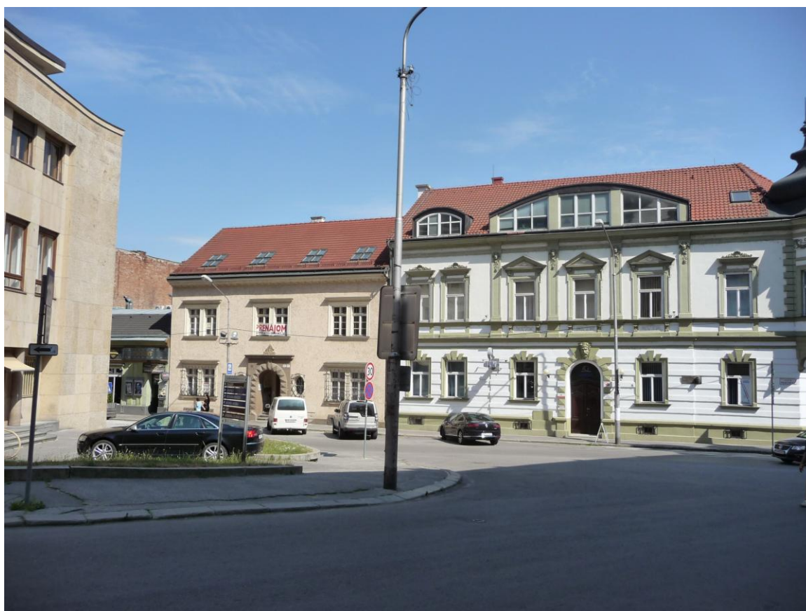
33. Pohľad z Mierového námestia na objekty č. 35 a č. 37 na Palackého ulici
