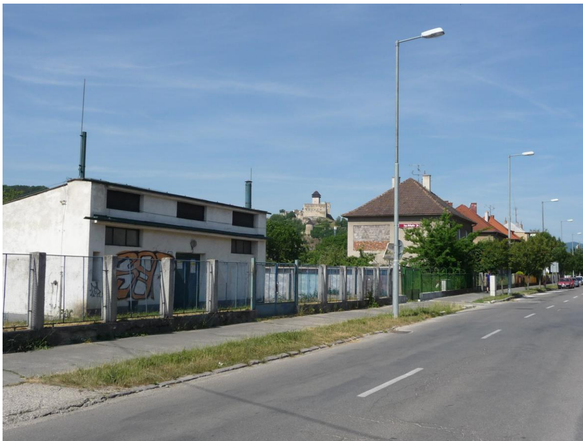
Pohľad č. 5 - z Hodžovej ulice -od zimmého štadióna M. Gáboríka
