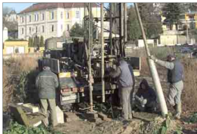
Doplňujúci geologický prieskum v lokalite bývalých Masarykových kasární spočíval v kopaní a vŕtaní geologických sond Foto (jč)
