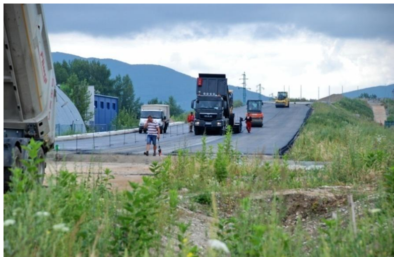
budovanie privádzača na diaľnicu na Zlatovská ul.
