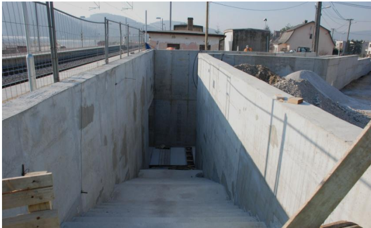
budovanie podchodu v Opatovej
