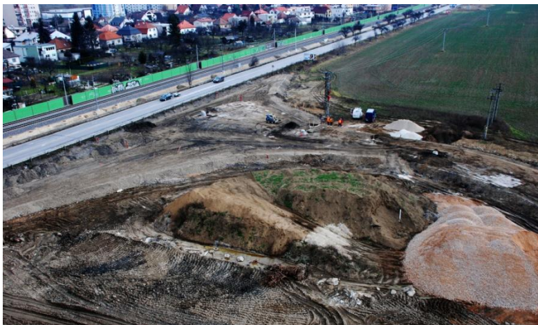
stavenisko kruhového objazdu Pred poľom 25.02.2014
