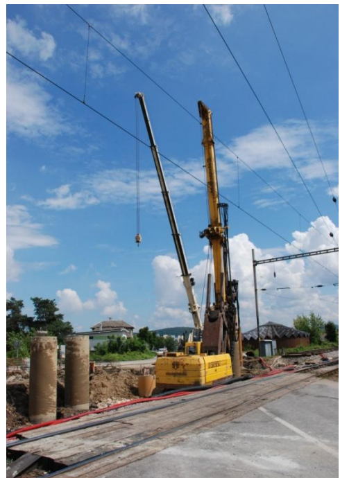
ťažké mechanizmy sa zahrýzli do podložia železničného priescestia
