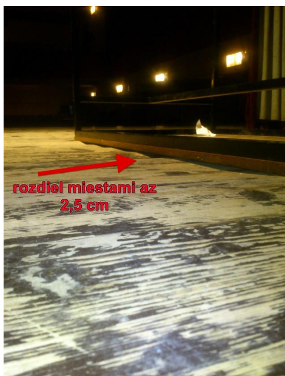
stav pred rekonštrukciou palubovky
