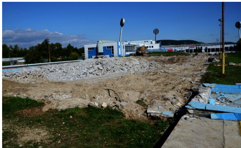
Toto zostalo z plaveckého bazéna plavárne
