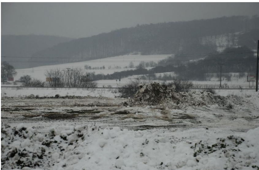
práce začali odhňaním ornice z lokality, kde bude nadjazd
