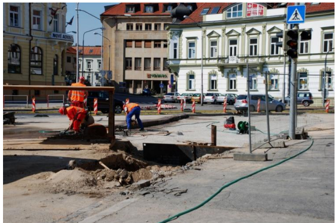
posledné terénne úpravy pred položením asfaltu
