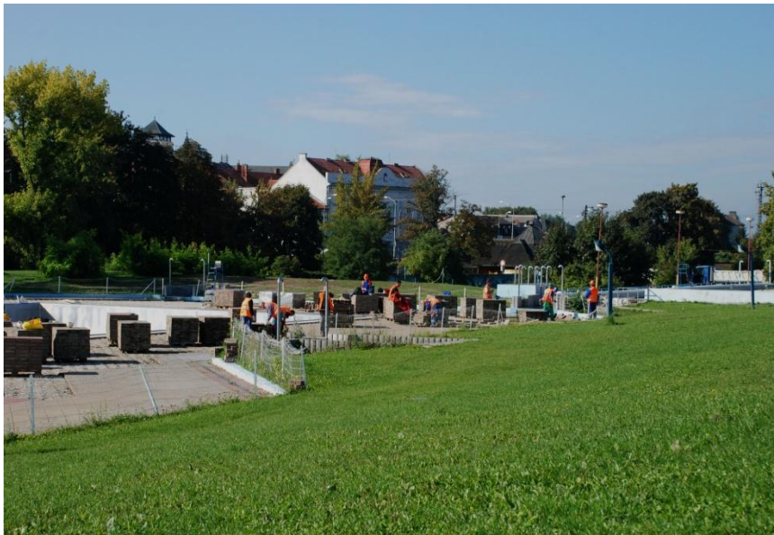
Asanačné práce od prvých septembrových dní intenzívne prebiehali
