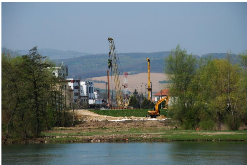
začiatok výstavby nového železničného mosta od Istebníka
