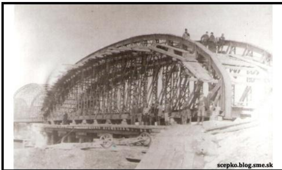
Železničný most cez Váh pri Trenčíne počas stavby železnice Trenčín - Žilina. Rok 1883. (zdroj: www.mdc.sk )
