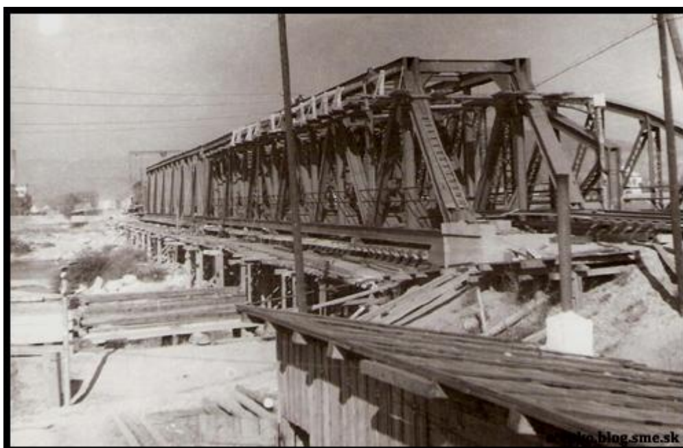
Výstavba nového mosta po vojne. (archív ŽSR - MDC)
