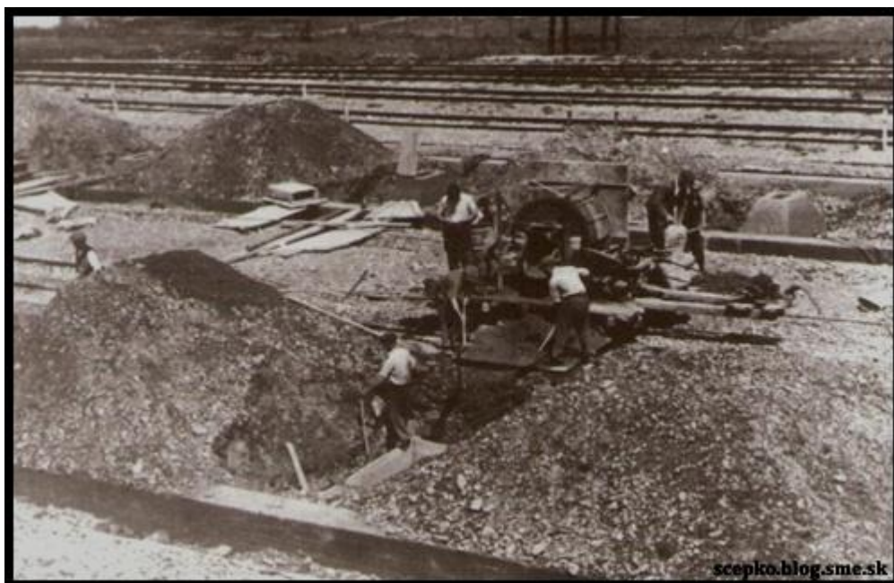
Práce na budovaní koľajiska. (archív ŽSR-MDC)
