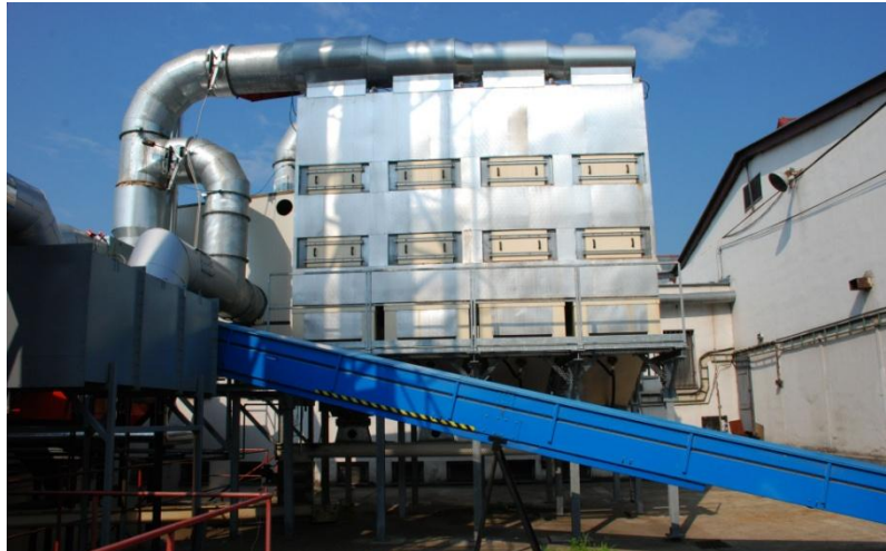
nové filtračné zariadenie
