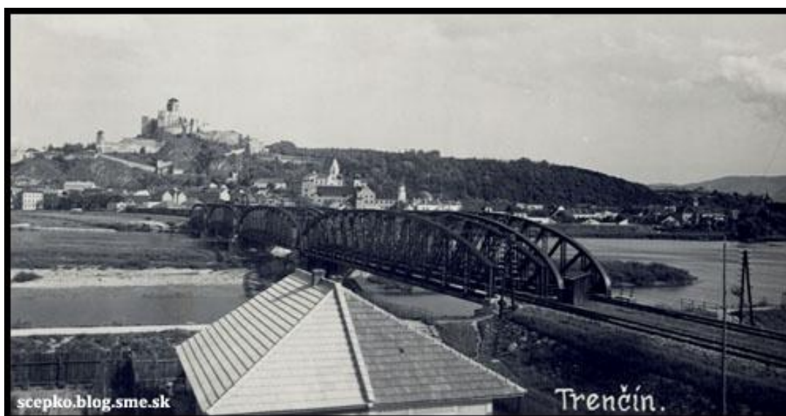
Železničné mosty pred II. svetovou vojnou. (Zdroj: zelezni-ca.railnet.sk , zbierka Martina Entnera)
