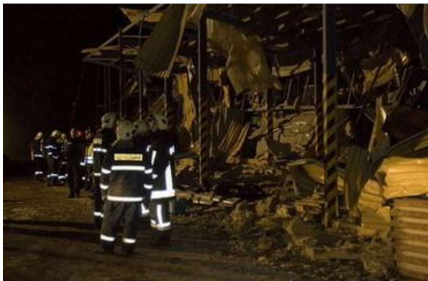
silu detonácie sa prejavila v priamej deštrukcii objektov
