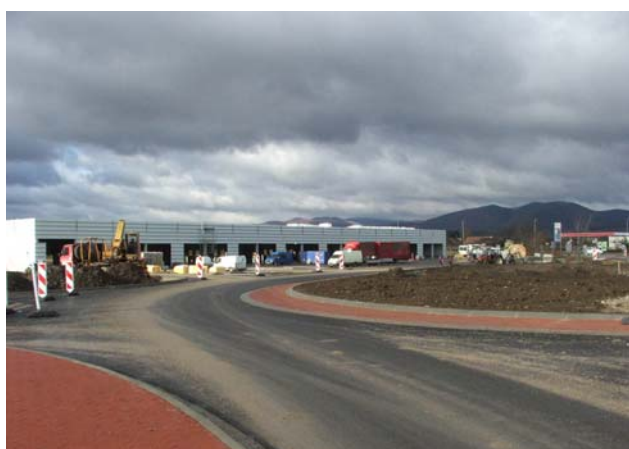
kruhový objazd a v pozadí rozostavaný objekt Baumaxu
