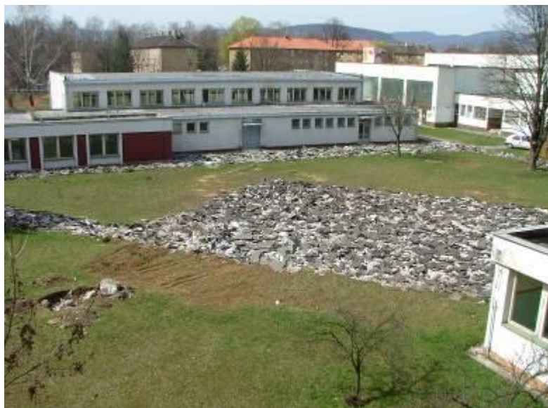
rekonštrukčné práce sa začali
