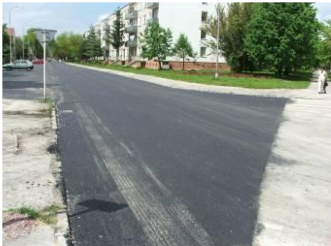
Ulica Dlhé Hony po rekonštrukcii
