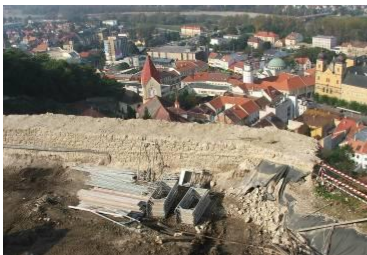
po asanácii homej časti západného opevnenia Trenčianskeho hradu sa otvorili nové pohľady
