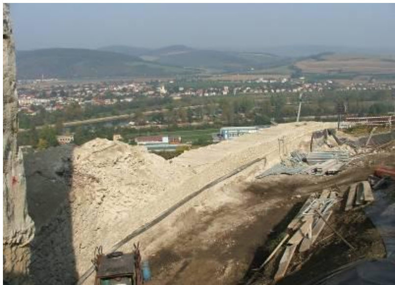
pohľad na asanovanú časť západného opevnenia Trenčianskeho hradu
