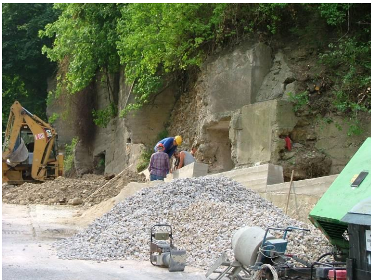
práce na opornom múre na Ulici Homý Šianec sa začali
