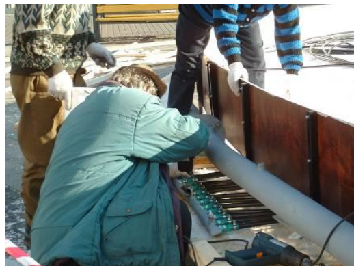
Montáž mantinelov a chladiacich trubiek
