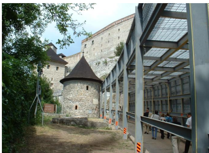
ochranná bariéra pre návštevníkov tesne pod pokladňou
