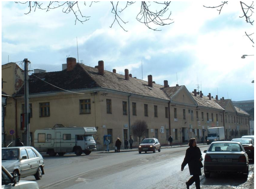
Severojižný pohľad na objekt kasární
