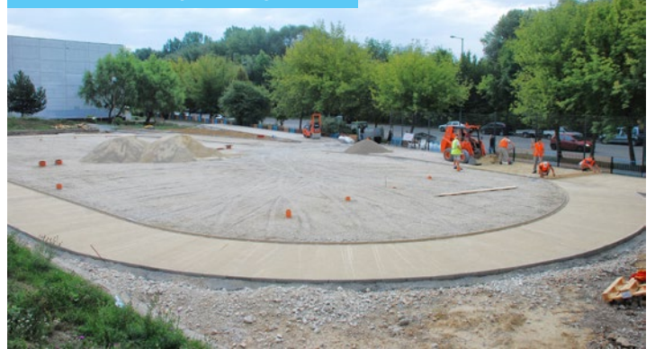
Rekonštrukcia športoviska v areáli ZŠ na Východnej ulici
