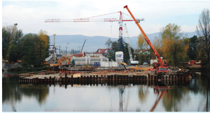
V Trenčíne napreduje i výstavba nového železničného mosta.
