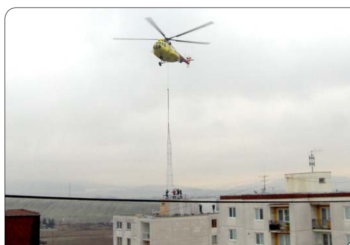
> V januári pútal pozornosť obyvateľov sídliska Juh II vrtulník, pomocou ktorého namontovali na strechu stožiar vykrývača telekomunikačnej spoločnosti. Antonín Galeta
